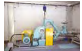
施工例:南木曽町細ノ洞発電所 令和2年12月竣工
